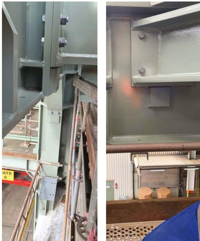
**Bild 1, 2** Der vertikale Spalt zwischen der Kopfplatte des Anschlussträgers und der Aufnahme des Querträgers, und der horizontale Spalt zwischen Knagge und Kopfplatte des Anschlussträgers wurden mit MM1018 kraftschlüssig verfüllt (linkes Bild). Im rechten Bild ist die Spaltsituation zwischen Knagge und Kopfplattenstoß zu erkennen.
