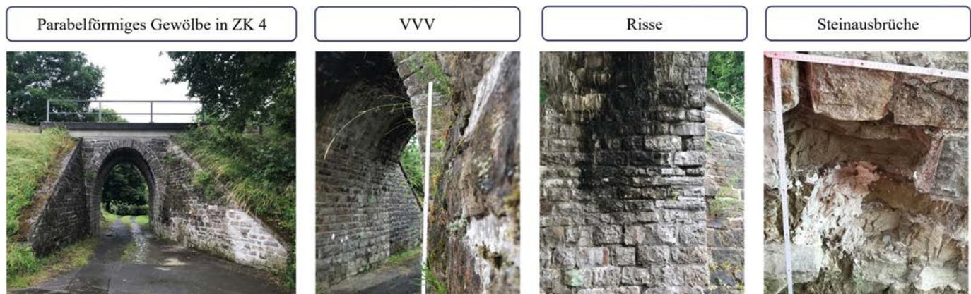
**Bild 9** Steiles Gewölbe mit den Schadensarten Riss, Steinausbruch und VVV [15]
