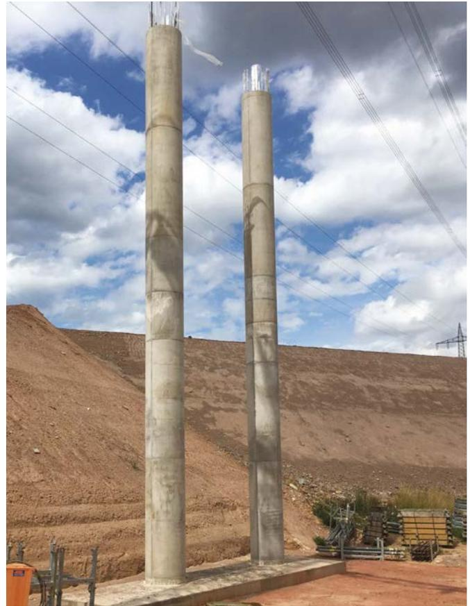
**Bild 2** Die fertig betonierten Betonpfeiler sind 13,80 bzw. 15,50 m hoch und haben einen Durchmesser von 1 m; sie wurden in jeweils zwei Takten geschalt und betoniert.
