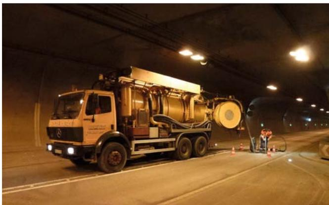
**Bild 1** Reinigungsarbeiten an der Tunnellängsleitung (Quelle: Jörg Mell/Hessen Mobil)
