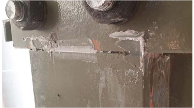
**Bild 4** Hier sieht man den fertig injizierten Spalt zwischen Knappe und Kopfplattenstoß, vor dem finalen Säubern.
