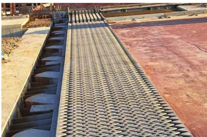
**Bild 3** Lösbarer Fahrbahnübergang: Rechts bereits eingebunden, links noch offen – weil dies die besondere lösbare Verbindung wird und der Magerbeton noch nicht eingebaut ist.
