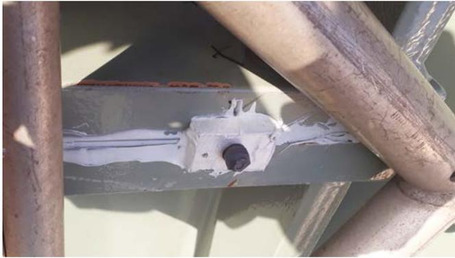
**Bild 3** An den kraftschlüssig abgedichteten, fertig injizierten Schraubenverbindungen wurde nach Aushärtung der Packer entfernt. Abschließend erfolgte eine Säuberung der MM1018 Seal-Abdichtung.
