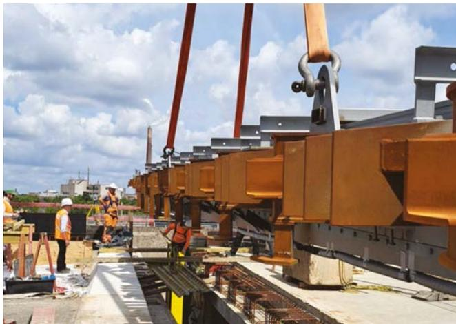
**Bild 2** Einhub eines großen Fahrbahnübergangs im August 2023
