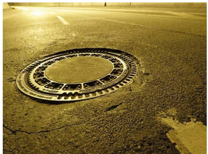
**Bild 2** Schäden im Bereich der Schachtdeckel (Quelle: Christian Bornschier/Hessen Mobil)
