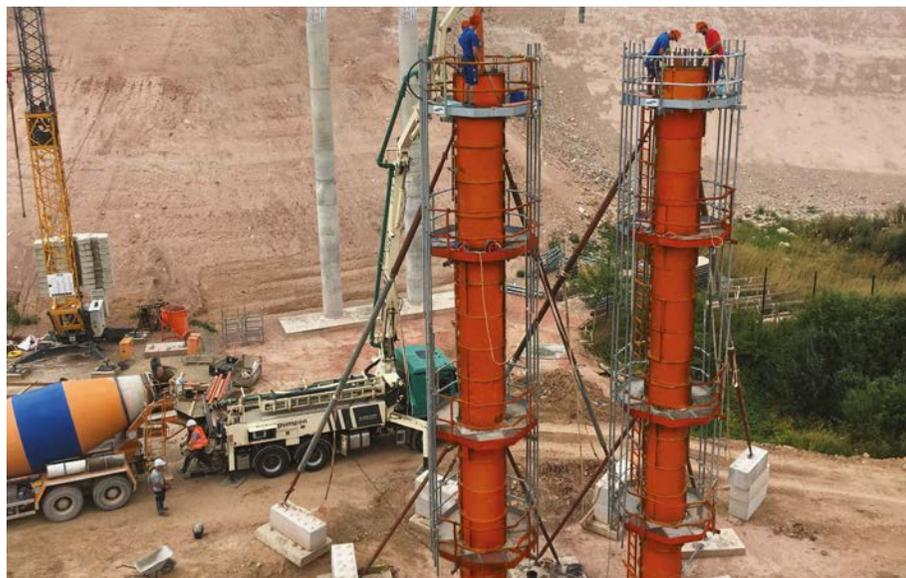
**Bild 1** Die Autobahnbrücke bei Herleshausen in Hessen (Bauwerk 16) wird Teil der neuen A 44 werden. Der 5. Bauabschnitt wird voraussichtlich im Frühjahr 2025 fertiggestellt; die Brücke im Frühjahr dieses Jahres (bei Red.-Schluss noch unklar). Die hohen Pfeiler wurden mit der Rundstützenschalung von PASCHAL geschalt.
