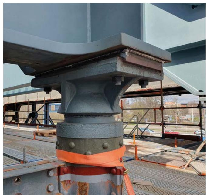
**Bild 12** Pendelstütze mit aufgearbeitetem Lager und neuem Überbau (Quelle: DB AG)
