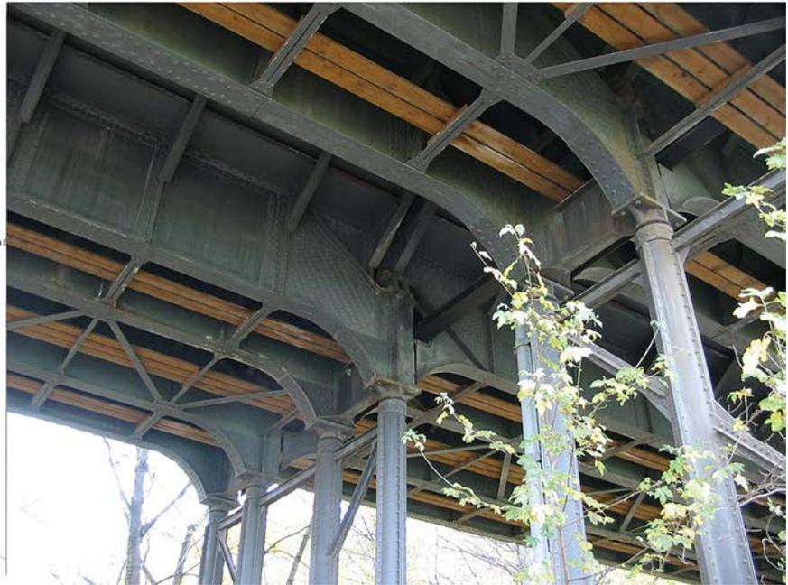
**Bild 9** Pendelstützen im ursprünglichen Zustand
