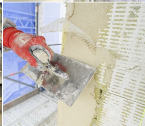
Bild oben: Abbruch der alten Fassadendämmung mit Flex, Spaten und Stemmmaschinen. Bild unten: Anputzen des neuen Armierungsgewebes auf der Dämmplatte.
